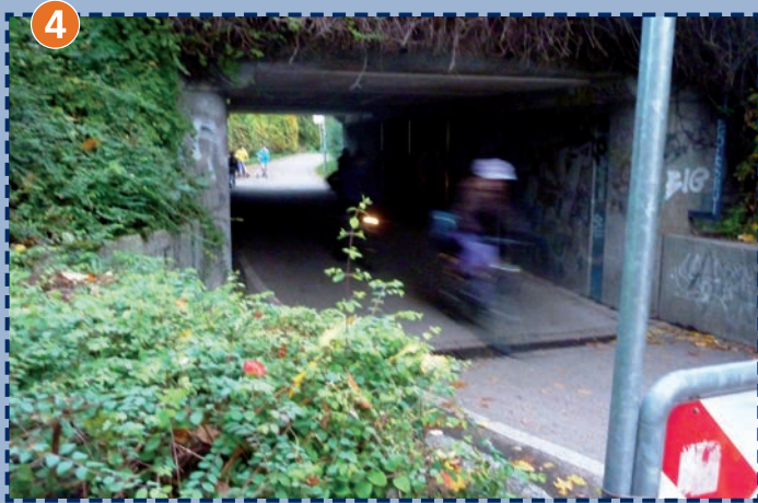
Vorsicht Radfahrer! Achtung Rollerfahrer: beim Ablaufgitter bitte schieben!
