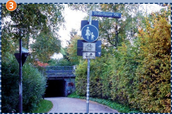
S-Bahn-Unterführung Holledauer Straße
